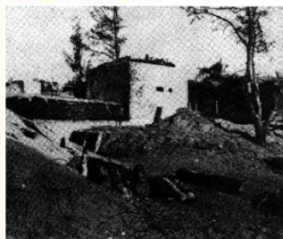
Betonunterstand auf der Düne
